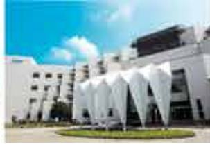
台南研發中心 (鑽石級綠建築)
